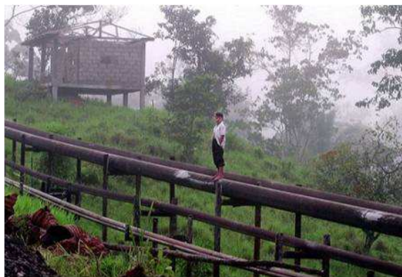
500 km de pipeline, parcourant le pays des puits au port, a eu des fuites déversant dans la nature près de 64 000 m 3 de brut (Texaco, 2007) - Photo L.Dematteis, K.Szymczak
